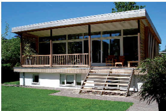
Het betonnen souterrain met slaapkamers vormt de fundering.
