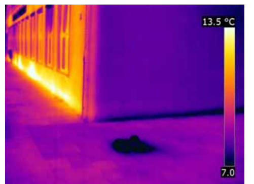
Typisch Nederlands gebouw. Warmte lekt snel (en onnodig) weg achter de radiatoren (boven de vloer) en de CV-buizen (onder de vloer) die meestal tegen de buitengevel zijn aangebracht.
